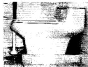
Altura WC modificada en obra para alcanzar la altura adecuada.
